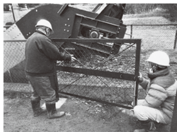
ネットフェンス修繕
