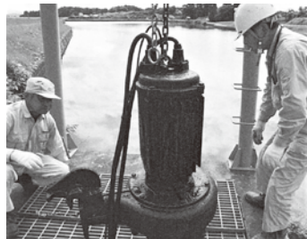
水中ポンプ整備
