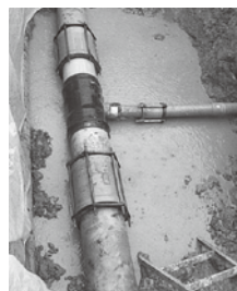
パイプライン修繕
